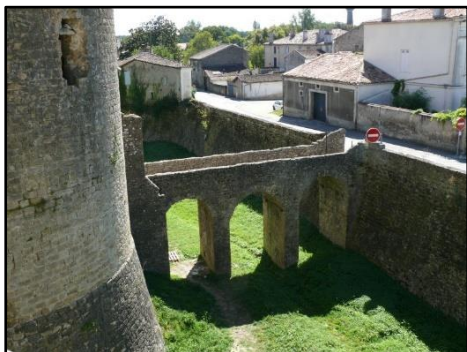
Douves et pont d'accès
