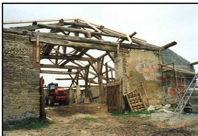
Travaux de rénovation en 1998
